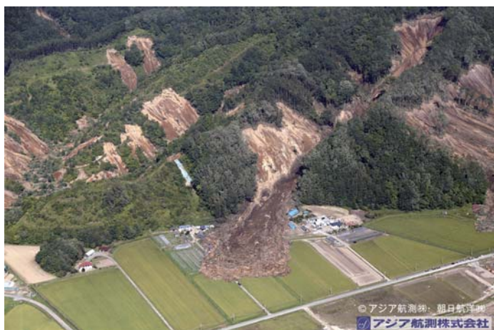
北海道胆振東部地震の被害状況
